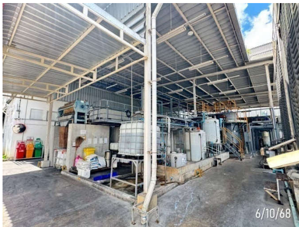
รูปที่ 2-10 ระบบบำบัดน้ำเสียทางเคมี
